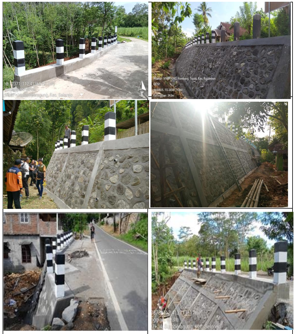
Gambar 3. 4 Mitigasi Struktural pembangunan Talud
